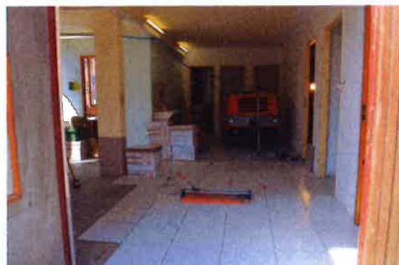
Photo du rez-de-chaussée en cours de travaux
