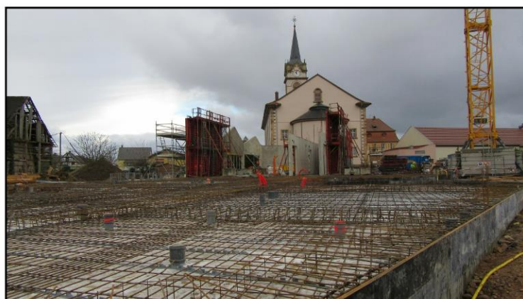
Préparation des dalles, janvier 2019
