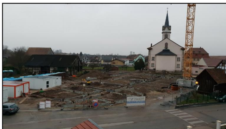
Les fondations sont faites, novembre 2018
