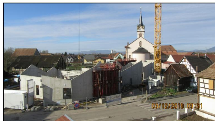
Fin des murs extérieurs, mars 2019
