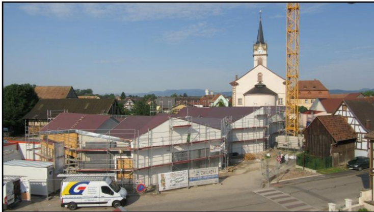
Fin de la toiture, juin 2019
