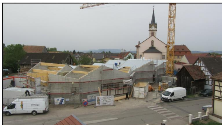
Pose de la charpente, avril 2019
