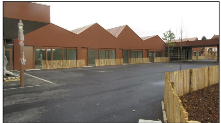
Fin des aménagements extérieurs, décembre 2019
