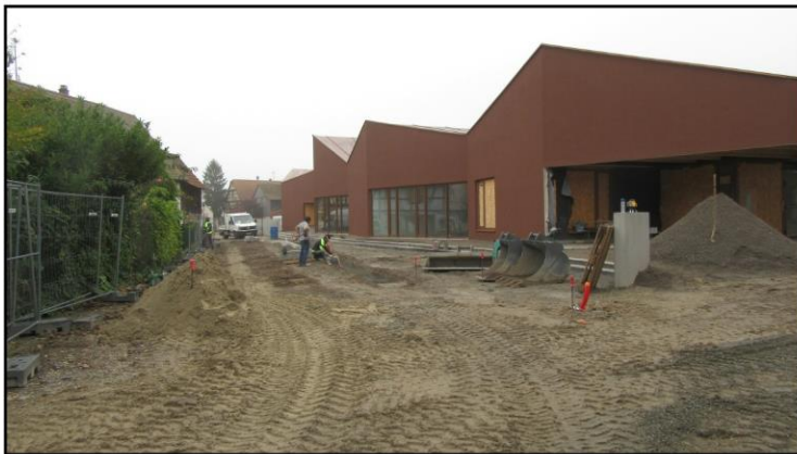
Terrassement des abords, octobre 2019
