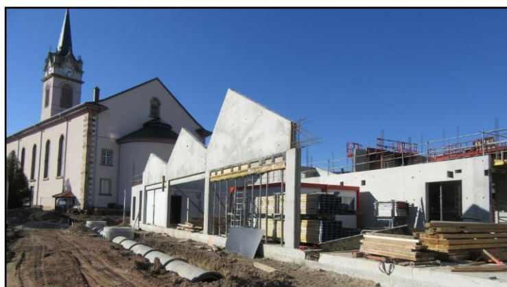
Premiers murs extérieurs et canalisations, février 2019
