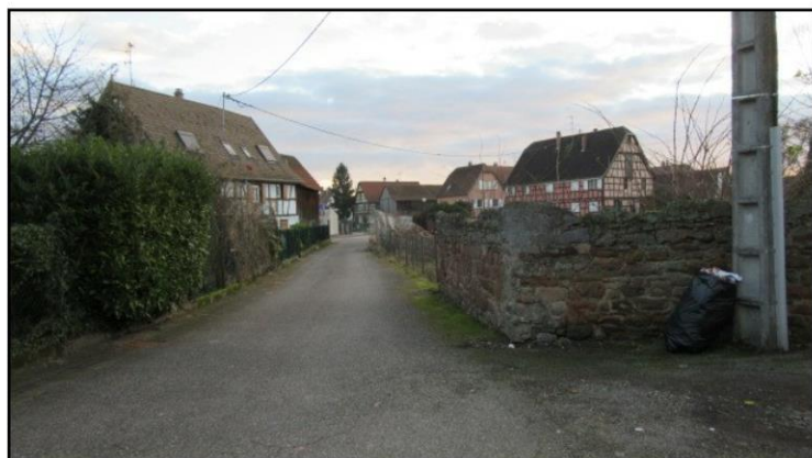
Photo du site avant les travaux, décembre 2017
