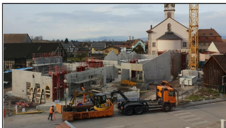
Suite des murs extérieurs, février 2019
